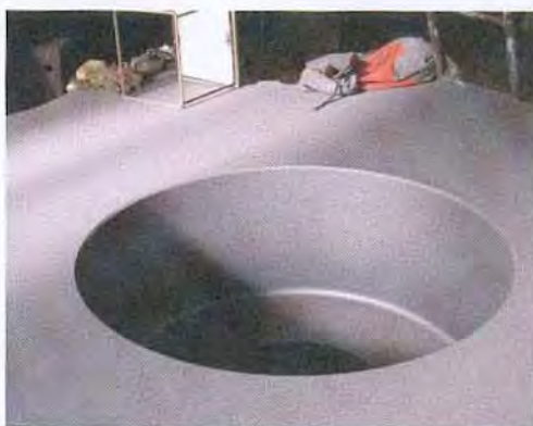
Perçage de la plaque d'appui du sommier
