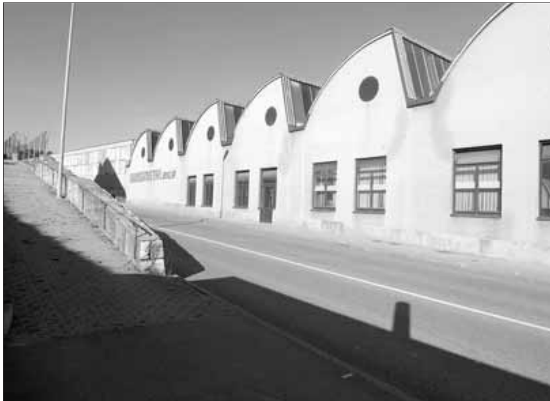
USINE 1 C'est derrière ces murs qu'a eu lieu l'explosion.
