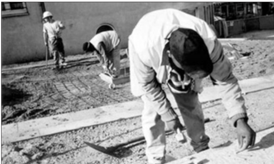
Un référendum mettrait au centre du débat le chantier – permanent – de destruction des droits et de précarisation sociale mis en place par les possédants.
